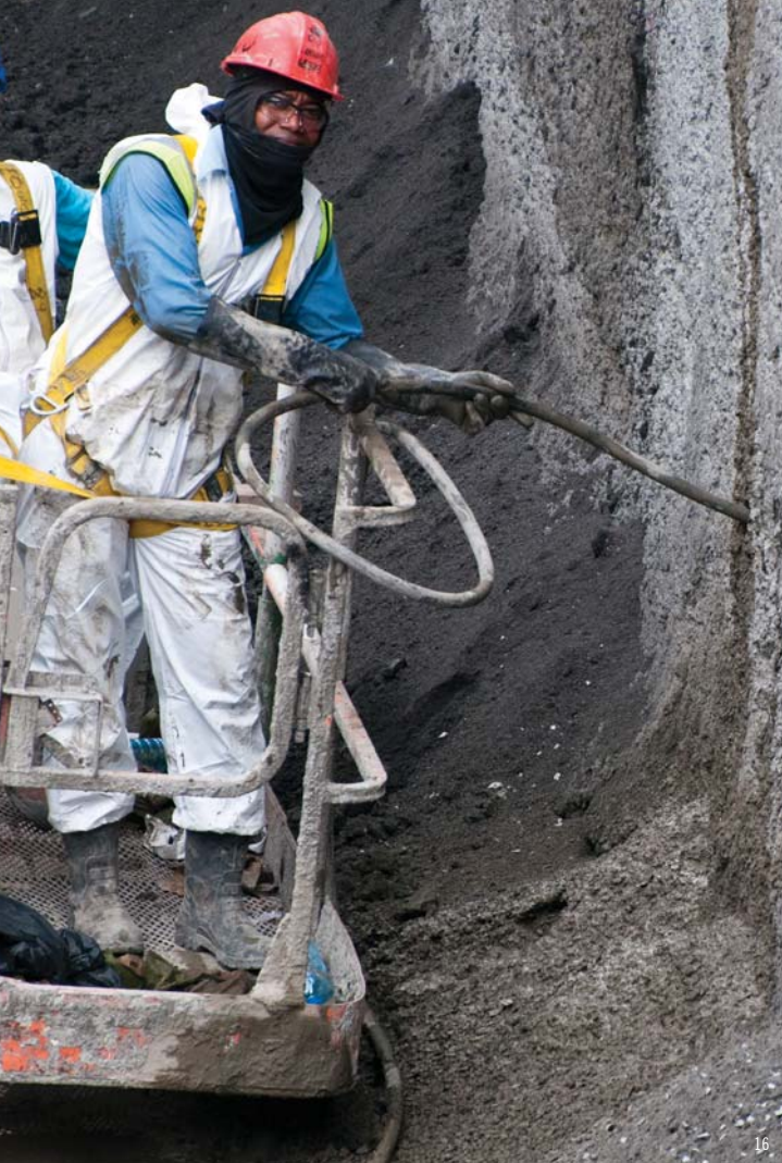
LECHADA DE COMPACTACIÓN
